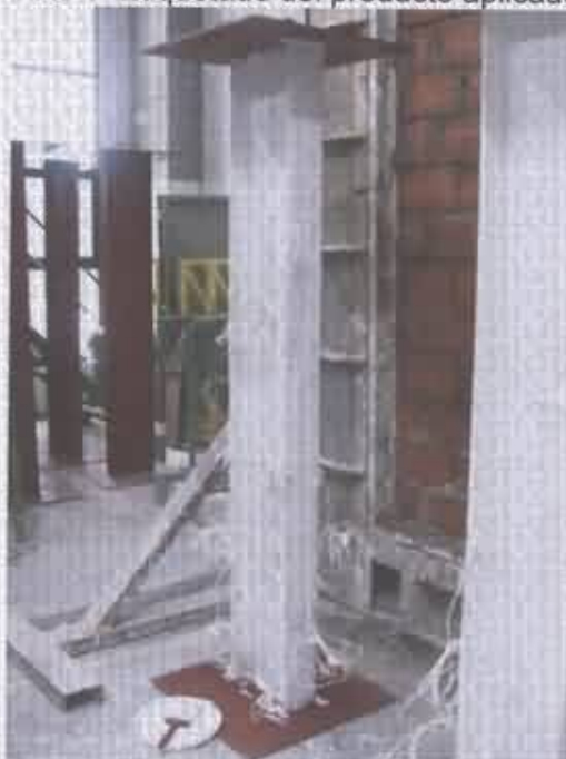
Foto 2- Aspecto de los perfiles en proceso de preparación
