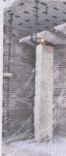
Foto 6- Aspecto del Perfil 1 una vez finalizado el ensayo, en el momento en que se realiza la apertura del horno.
