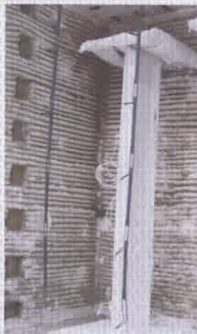
Foto 4- Vista del Perfil 1 en el interior del horno previo a la realización del ensayo
