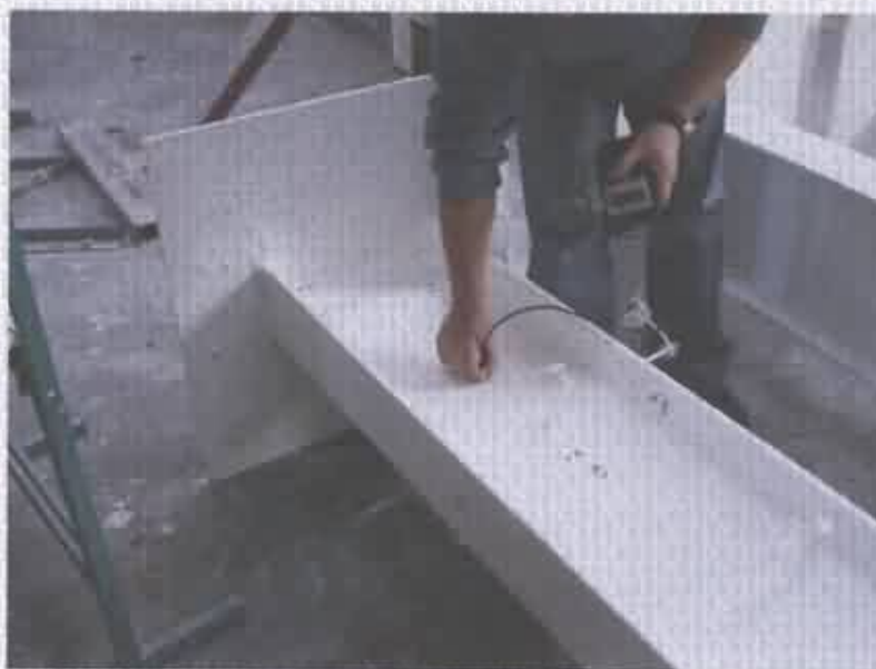
Foto 3- Medición de los espesores de pintura aplicados
