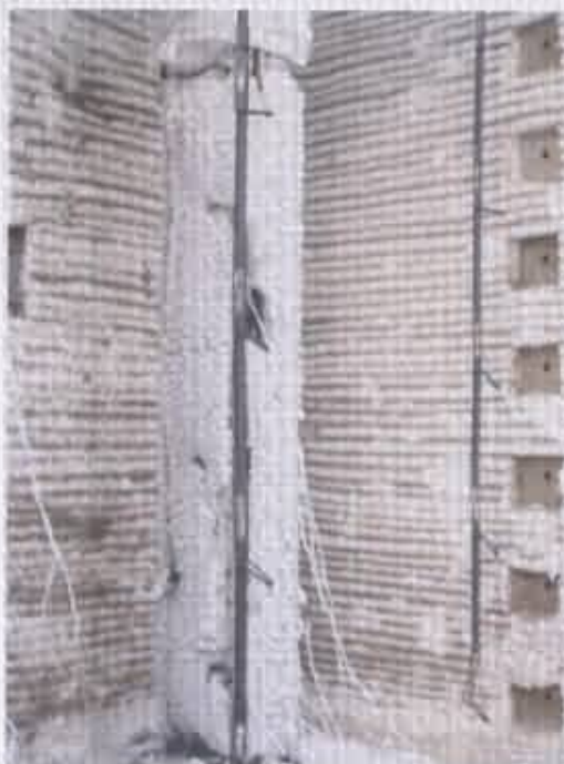
Foto 10- Aspecto del Perfil 2 una vez finalizado el ensayo, en el momento de la apertura del horno
